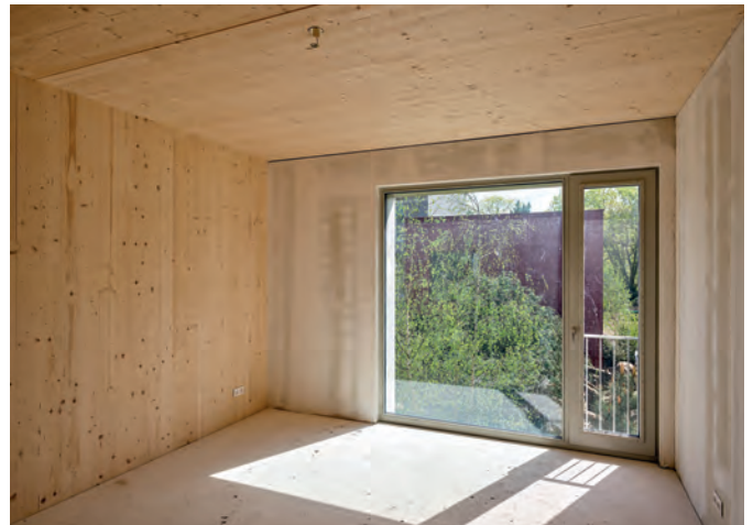
Interieur met deels hout, deels stucen gipsplaten in het zicht
