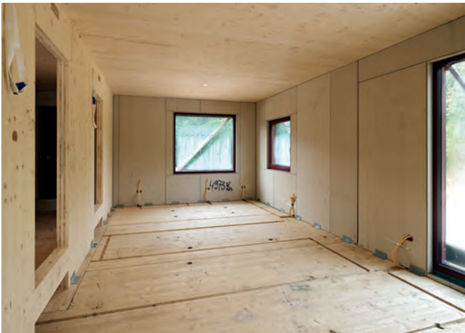
CLT-vloeren en -wanden en HSB gevels afgewerkt met gipsplaten.
