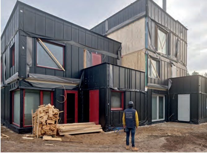
Het casco van geschakelde familiewoningen na de opbouw.
