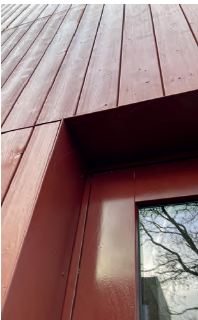
Gevelopening met metalen randprofiel in dezelfde kleur als gevel en kozijn.
