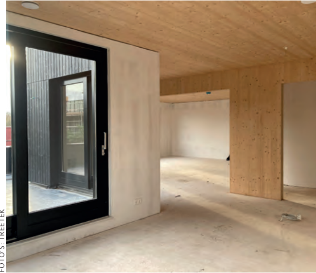
Interieur met karakteristieke CLT-wand en schuifpui
